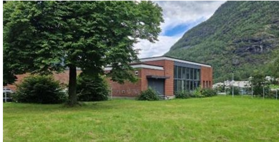
Pumpehus og basseng
