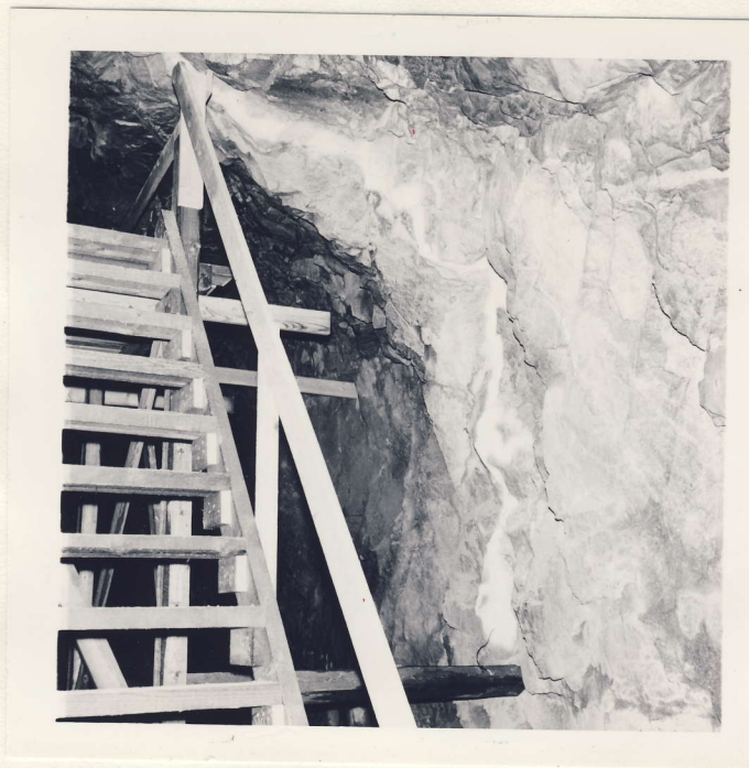
Foto 3. Tilkoblingen av ledningen ved enden av sinkbåndet (kvitt) i søndre tunnelvegg.
