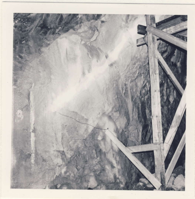
Foto 2. Ledningen tilkoblet enden av sink- båndet (kvitt) i nordre tunnelvegg med bjelken som ledningen er lagt langsetter bort til stillaset.
