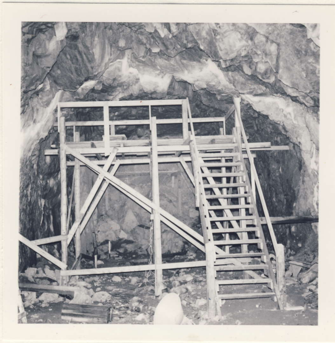
Foto 1. Stillaset som ble satt opp. Sinkbåndet sees som et lyst bånd i tunneltaket.
