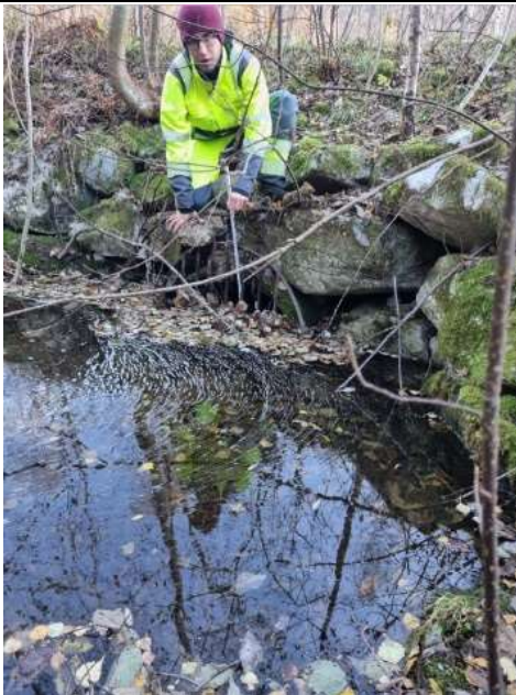
Punkt 4-2: Kraftig tilstoppa innløp. Basseng framfor med mykje masser og vegetasjon i.
