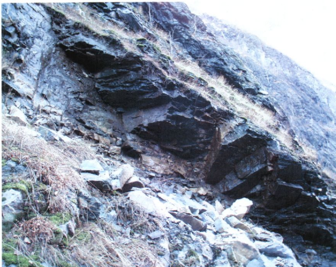
3: Fv. 303, Seimsdaltunnelen aust, sleppområde, 13-01-2005
