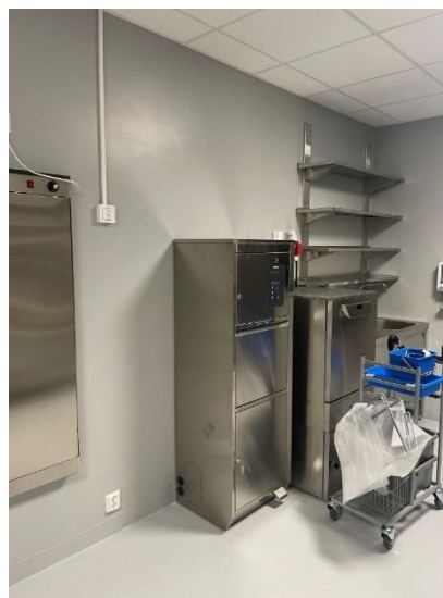
Figur 45: Illustrasjonsbilde frå skyljerom Åsaheimen, Bergen. Til venstre rein side, Til høgre urein side med gjennomstikkskap.
