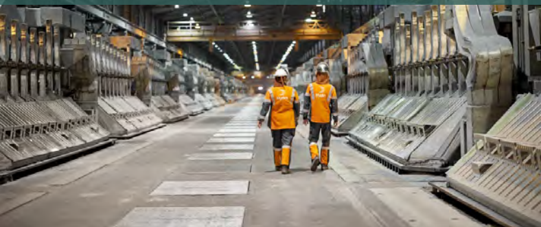
Nye teknologielement elektrolyse
